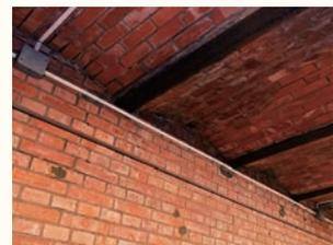
▲耐火床 煉瓦でできたアーチ状の床を鉄骨で支えている。
